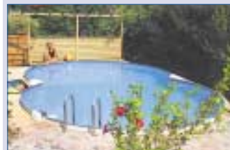
Kunststoffbeschichtetes Stahlbecken, in den Boden eingelassen.
